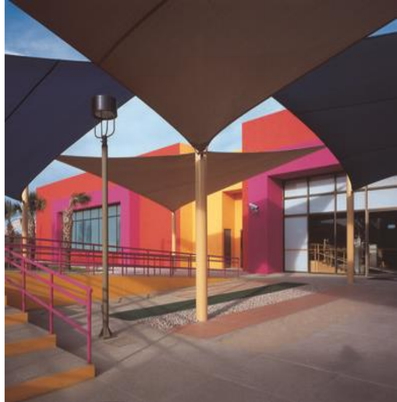
Toldo urbano adosado a edificación.
