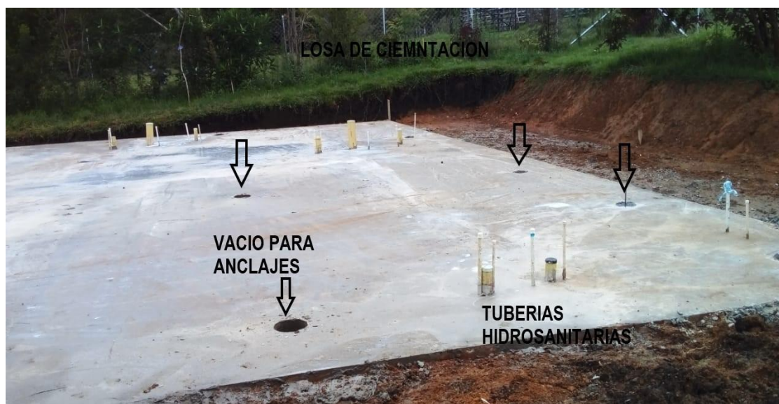
Ilustración 4. Losa de cimentación terminada
