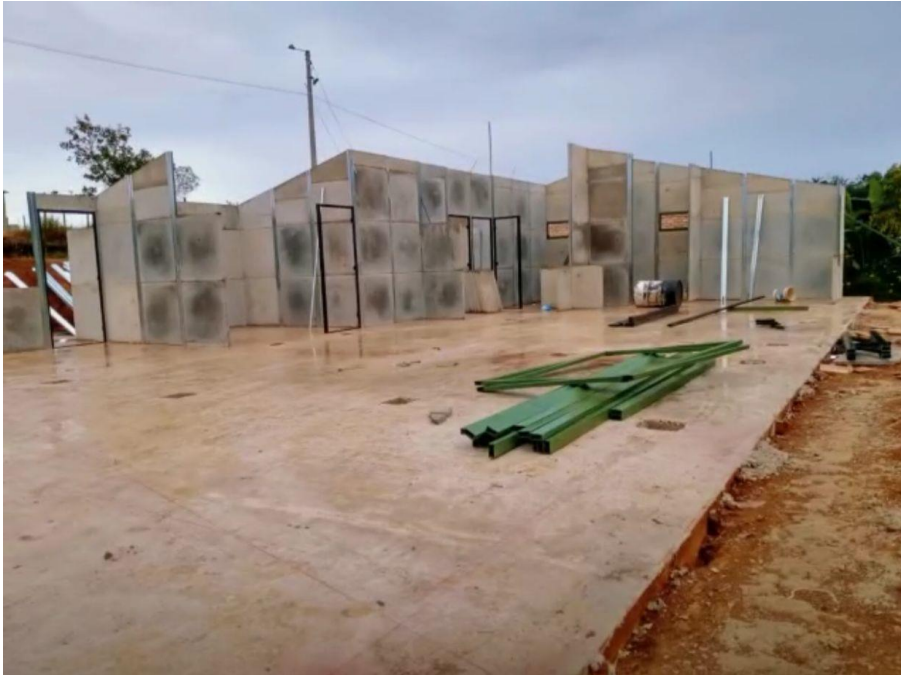
Ilustración 9. instalación de plaquetas y perfilería
