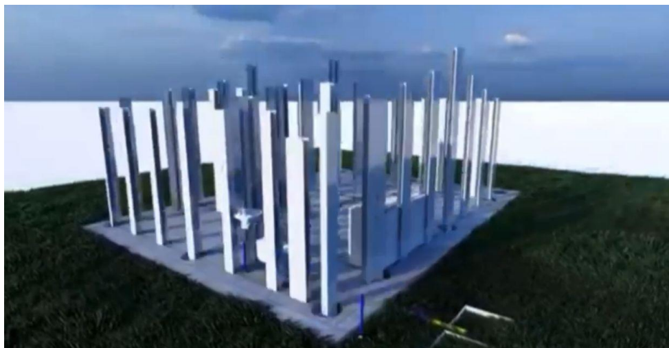
Ilustración 7. instalación de Perfilería y anclajes
