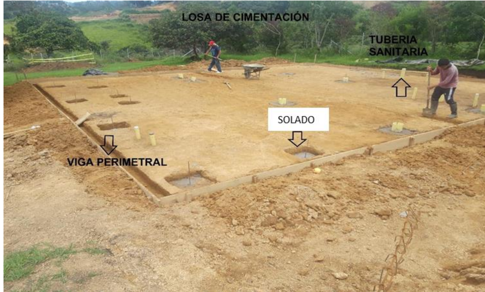
Ilustración 1. Instructivo de losa de cimentación
