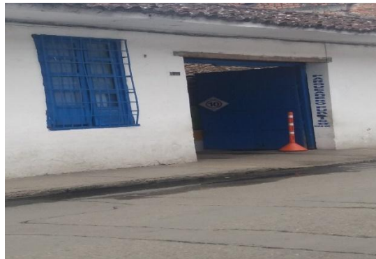
Imagen 4: Fachada principal del parqueadero acueducto
